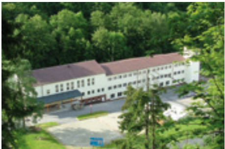
Werk 3 – Unterweißbach Transformatorenbau Facility 3 – Unterweißbach Transformers Production
