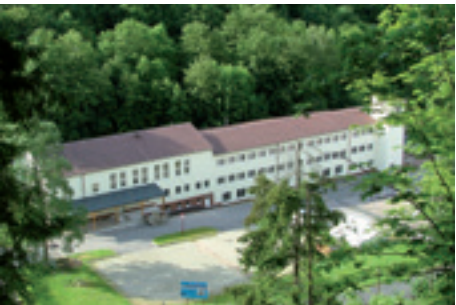
Werk 3 – Unterweißbach Transformatorenbau Facility 3 – Unterweißbach Transformers Production
