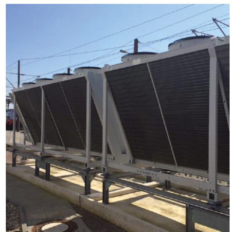
› technotrans Rückkühlsystem: Installation mehrerer Rückkühlsysteme bei einem Großprojekt im Bereich der Bahntechnologie
