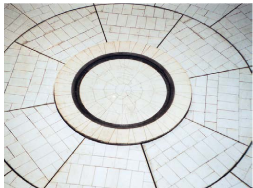
Auskleidung mit keramischen Kacheln
