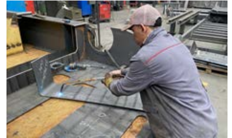
Vor der Anschaffung der Teilerichtmaschine mussten die Teile mühsam mit der Flamme gerichtet werden.
