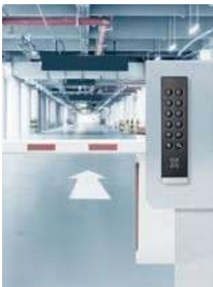
Montage an Schrankenanlagen
