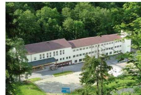
Werk 3 – Unterweißbach Transformatorenbau
