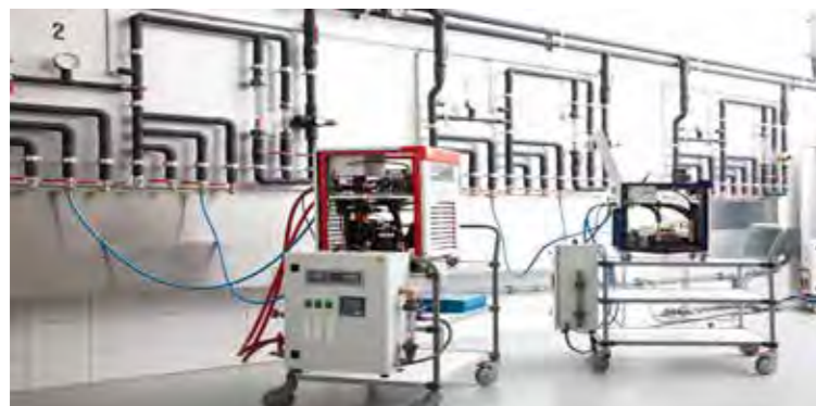
Unser Prüfraum für Systemtrenner und WG-Anlagen
