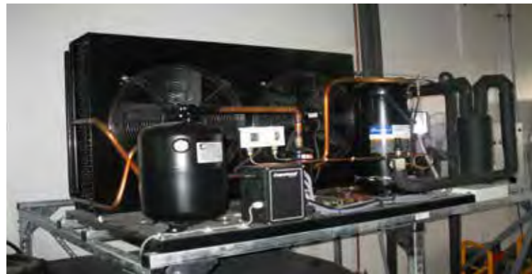
Wärmerückgewinnung im Prüfraum
