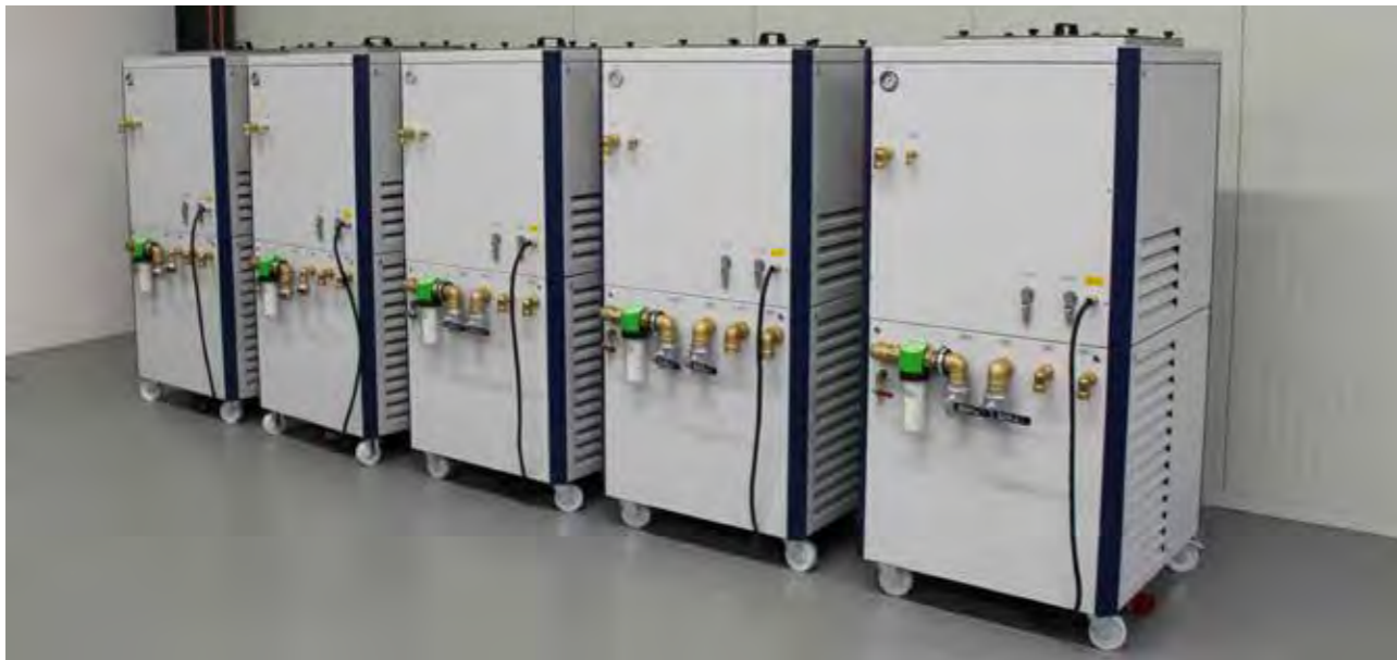
80 kW Systemtrenner mit Filter auf der Sekundärseite
