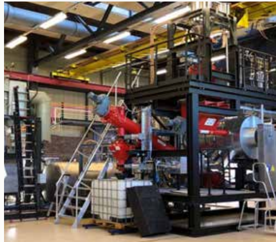
1 MW Versuchsanlage mit dem Torrgas / TAF / DBI - Verfahren zur Herstellung von Synthesegas aus torrefiziertem Abfall-Gebrauchtholz in Delfzijl / Niederlande; Geplant ist eine 25 MW Anlage
