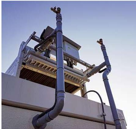
**Bild 1:** Hydraulischer und elektrischer Anschluss des zentralen Rückkühlers auf dem Dach des Betonhauses in Düsseldorf.
