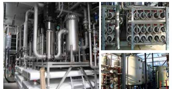
Aufbereitung von Flusswasser zu Kesselspeisewasser mittels Ultrafiltration, Kationentauscher zur Dekarbonisierung, Umkehrosmose, CO<sub>2</sub>-Entgasung und abschließendem Multistep-Ionentauscher
