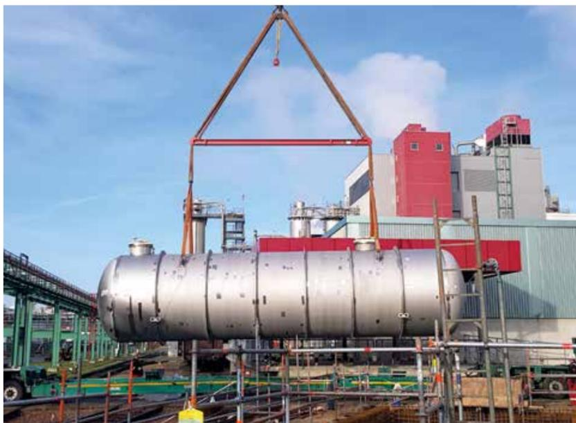
Der neue doppelwandige 100 m<sup>3</sup>-Ethylenoxid-Tank wird eingehoben.
