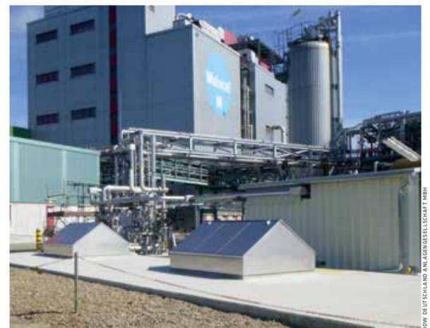
o.: Der Ethylenoxid-Tank ist in der Erde verlegt und sicher abgedeckt. Der letzte Schritt im Gesamtprojekt ist abgeschlossen! Eine reduzierte Anzahl von Ethylenoxid-Verladungen aus Kesselwagen in dem neuen unterirdischen Ethylenoxid-Tank führt zu einer geringeren Gefährdung im Gesamtbahnverkehr, da weniger Kesselwagen mit Gefahrgut transportiert werden.
