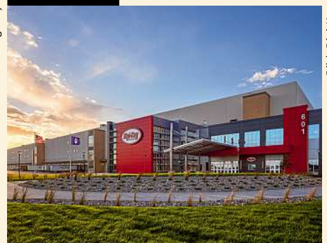
Distributionshalle: Mitte 2021 empfängt eine neue Halle Mitarbeiter und Kunden von Digi-Key.
