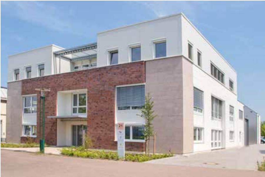
Firmensitz im Stahlwerk Becker in Willich
