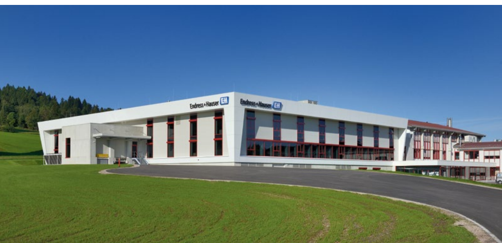
Der Endress+Hauser-Standort Nesselwang im Allgäu ist innerhalb der Gruppe das Kompetenzzentrum für Temperaturmesstechnik, Systemkomponenten und Energielösungen.
