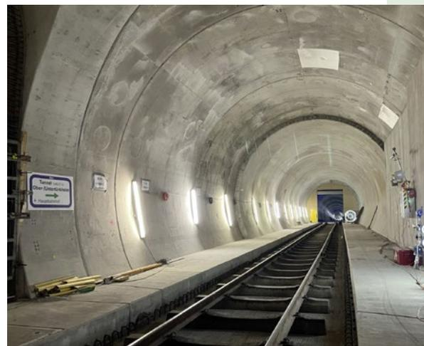
*Bild oben: Rhomberg Sersa wurde im Rahmen des Projekts Stuttgart 21 mit der Erstellung des Masse-Feder-Systems und der festen Fahrbahn im Bereich von Süd- und Nordkopf des Stuttgarter Hauptbahnhofs beauftragt.
