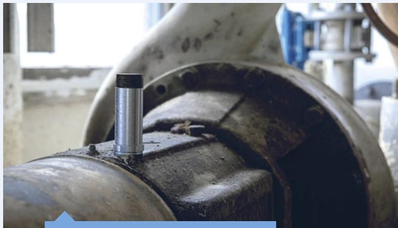
Die Integration eines Messknotens ist unkompliziert: Er kann wie im Bild über eine Gewindebohrung direkt am Maschinengehäuse verschraubt werden. Weitere Optionen sind die Befestigung mittels magnetischem Adapter oder Klebe-Adapter.
