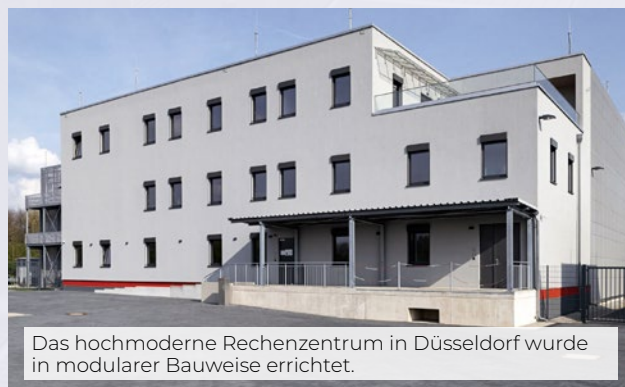
Die Rechenzentren von DC1 sind jetzt schon auf künftige Anforderungen wie die des EnEFG vorbereitet.
