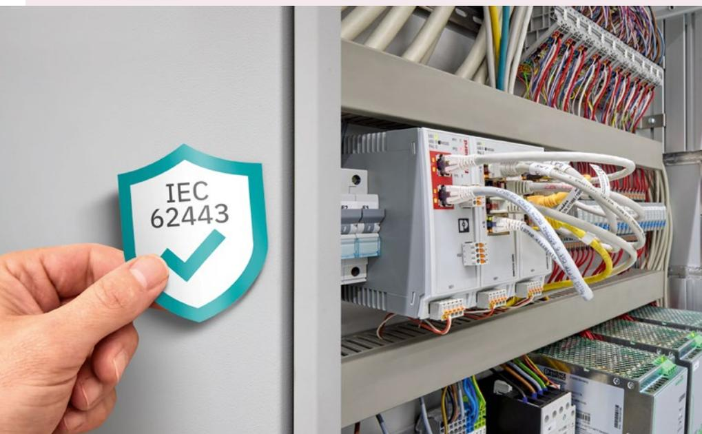
**Zu den Maßnahmen der Normenreihe IEC 62443 gehören zum Beispiel die Konfiguration und Segmentierung der Netzwerke, der Schutz von Daten bei ihrer Speicherung und Übertragung sowie die Authentifizierung der Benutzer.** Bilder: Phoenix Contact
