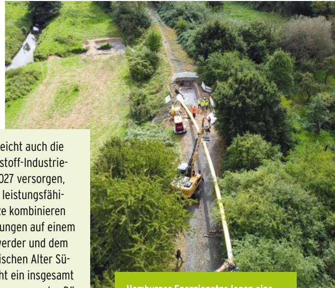
Hamburger Energienetze legen eine kombinierte Leitungstrasse für die Elbinsel Finkenwerder und untertunneln das Gewässer Aue.
