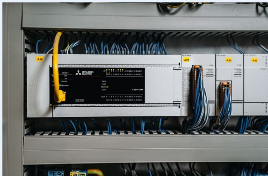
Hardware von Mitsubishi Electric ist über Generationen hinweg abwärtskompatibel. Das gilt auch für die Kompaktsteuerung Melsec FX5U-64MR/DS, mit der die Tramwaschanlage gesteuert wird.
