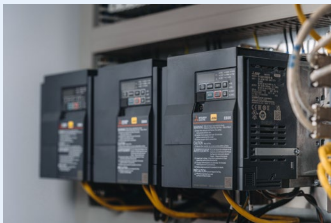
Die Frequenzumrichter der FR-E800 Serie von Mitsubishi Electric ermöglichen eine energieeffiziente Regelung von Bürsten und Pumpen.
