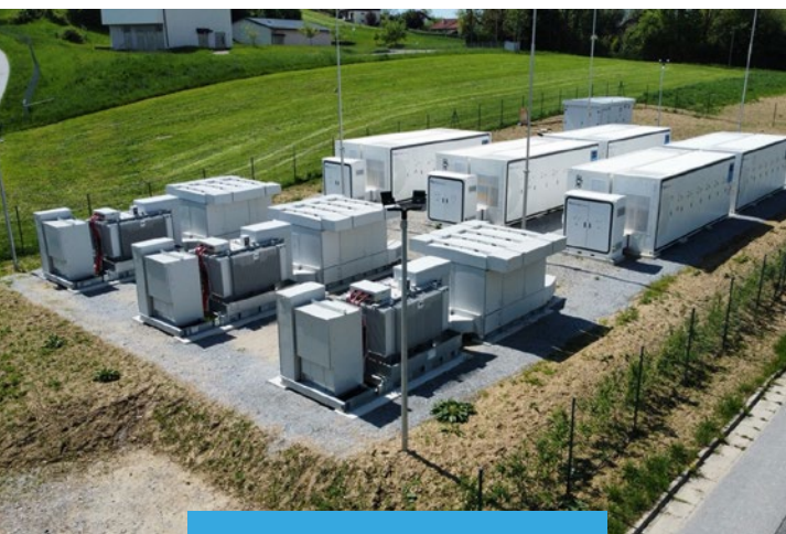
In Crottendorf im Erzgebirgskreis realisiert Big Battery Deutschland einen Großbatteriespeicher mit 15 MW Leistung und 30 MWh Speicherkapazität. Bild: Big Battery Deutschland
