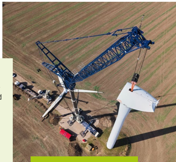
Im Windpark Biere-Borne bei Magdeburg hat Hagedorn Service erstmals sechs Anlagen komplett in Eigenregie demontiert. Bild: Hagedorn
