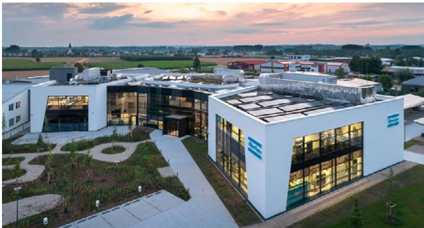
Energieoptimiert im ländlichen Raum: Das ECC mit seinen drei Baukörpern, ausgezeichnet mit dem BIM-Preis Bayern 2024, erfüllt den KfW-40-Standard und verfügt über LEED-Platin-Zertifizierung.
