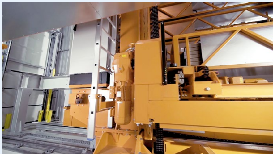
Für das von Baumalog konzipierte automatisierte Lager bei Retech lieferte Nord sechs Getriebemotoren mit Leistungen von 0,75 bis 3 kW sowie die dazu passenden Frequenzumrichter vom Typ NordAC PRO.
