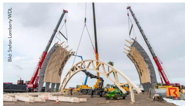
Das Holztragwerk des Luftschiffhangars setzt sich aus 15 Zweigelenkbögen von jeweils 26 Metern Höhe zusammen.
