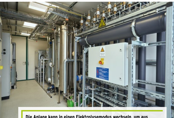
Die Anlage kann in einen Elektrolysemodus wechseln, um aus elektrischer Energie Wasserstoff oder Methan zu erzeugen.
