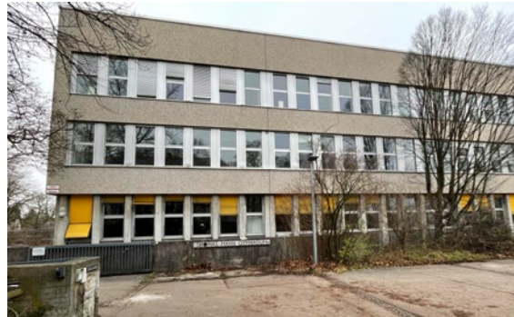
Vorher, nachher: Thomas-Mann-Gymnasium, München, aus den 1970er-Jahren und nach Generalsanierung (Bild unten).
