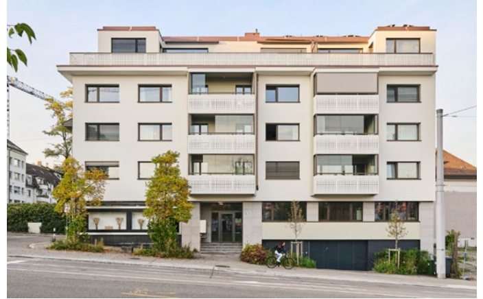
Nach Sanierung und Aufstockung: Das Mehrfamilienhaus präsentiert sich mit modernisierter Fassade und neuem Attikageschoss.
