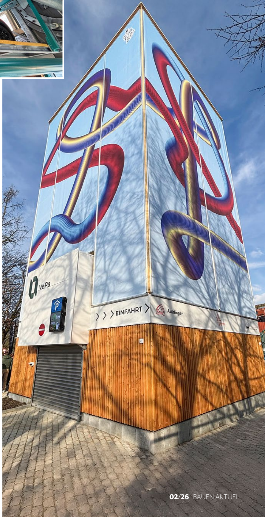
Platz für zwölf PKW: Die Fahrzeuge werden auf Plattformen abgestellt, die nach dem Paternoster-Prinzip bewegt werden.
