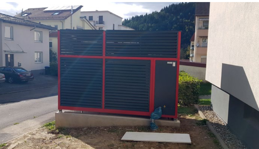
Die Wärmepumpe verfügt über zwei voneinander getrennt arbeitende Kältekreise, die ein breites Leistungsspektrum erlauben.
