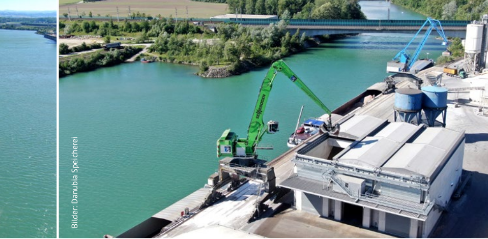
Bild links: Optimierter Umschlag und optimal genutzte Lagerkapazitäten: die neue Halle der Danubia Speichererei mit verschiebbarem Hallendach. Bild Mitte: Dank verschiebbarem Hallendach sind die drei Lagerkammern der Umschlaghalle von oben per Bagger beladbar. Bild rechts: Die drei Dächer lassen sich vollautomatisch öffnen und schließen und können unabhängig voneinander bewegt werden.
