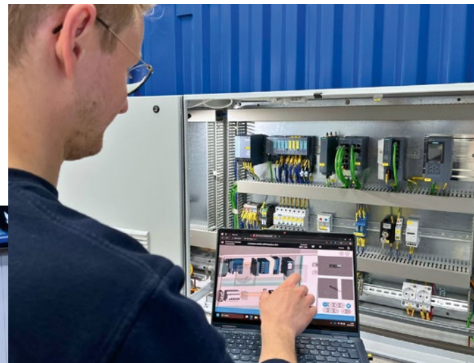
Der digitale Zwilling vor Ort: Eplan Smart Mounting zeigt den jeweils nächsten Arbeitsschritt bei der Schaltschrankmontage.
