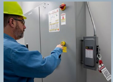
Anlagenbetreiber in Industrie und Schiffstechnik können per Tastendruck normgerecht prüfen, ob eine Anlage vollständig vom Stromnetz getrennt ist.
