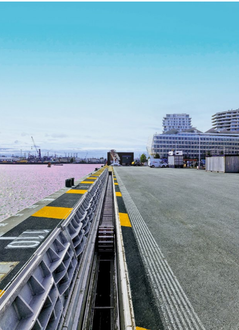
Energiekettensystem für Landstromanlagen gibt es nicht von der Stange.
