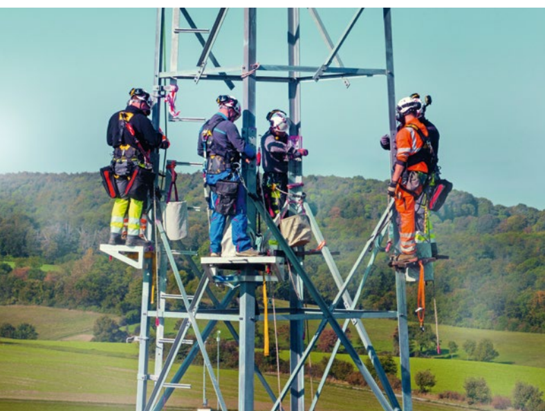
Cteam hat sich auf das Engineering und den Bau von Masten spezialisiert.
