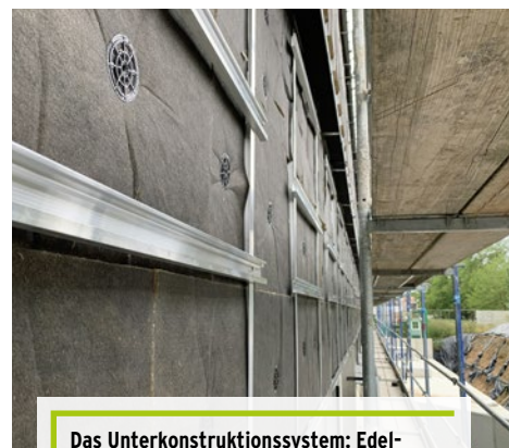
Das Unterkonstruktionssystem: Edelstahl-Wandhalter „FLH R“, T-Profile sowie die Tragprofile „ATK 103 P20“ und „ATK 103 V“ bilden eine wärmebrückenarme, zugelassene und montagefreundliche Basis für die „Solarwatt vision GM 3.0 construct“-Module. Bild: fischer
