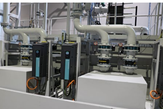
Links hinten im Bild sind die beiden Schmutzwasserabgänge für die Filtermodule zu sehen. Rechts befinden sich die zwei Reinmediums-abgänge, die in Redundanz die Maschinen mit gereinigtem Medium versorgen.
