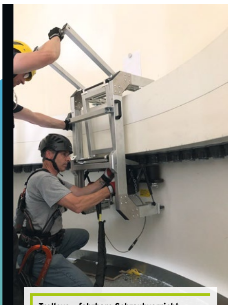
Trolleys – fahrbare Schraubvorrichtungen – werden im Turm der Windkraftanlagen an den Ringflanschen montiert, um die Turmsegmente automatisiert und ergonomisch zu verschrauben.
