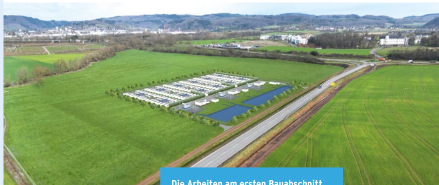
Die Arbeiten am ersten Bauabschnitt für den Batteriegroßspeicher in Wengerohr beginnen.
